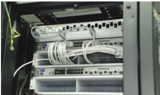
Кабельные организаторы R&M органично вписываются в архитектуру ЦОД, позволяя спрятать избыток коммутационных шнуров
